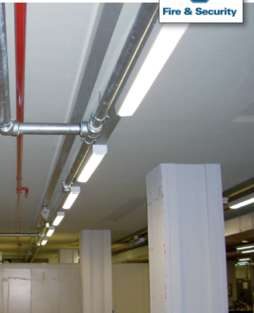
Installazione di tubazioni a soffitto Tyco Sapphire
